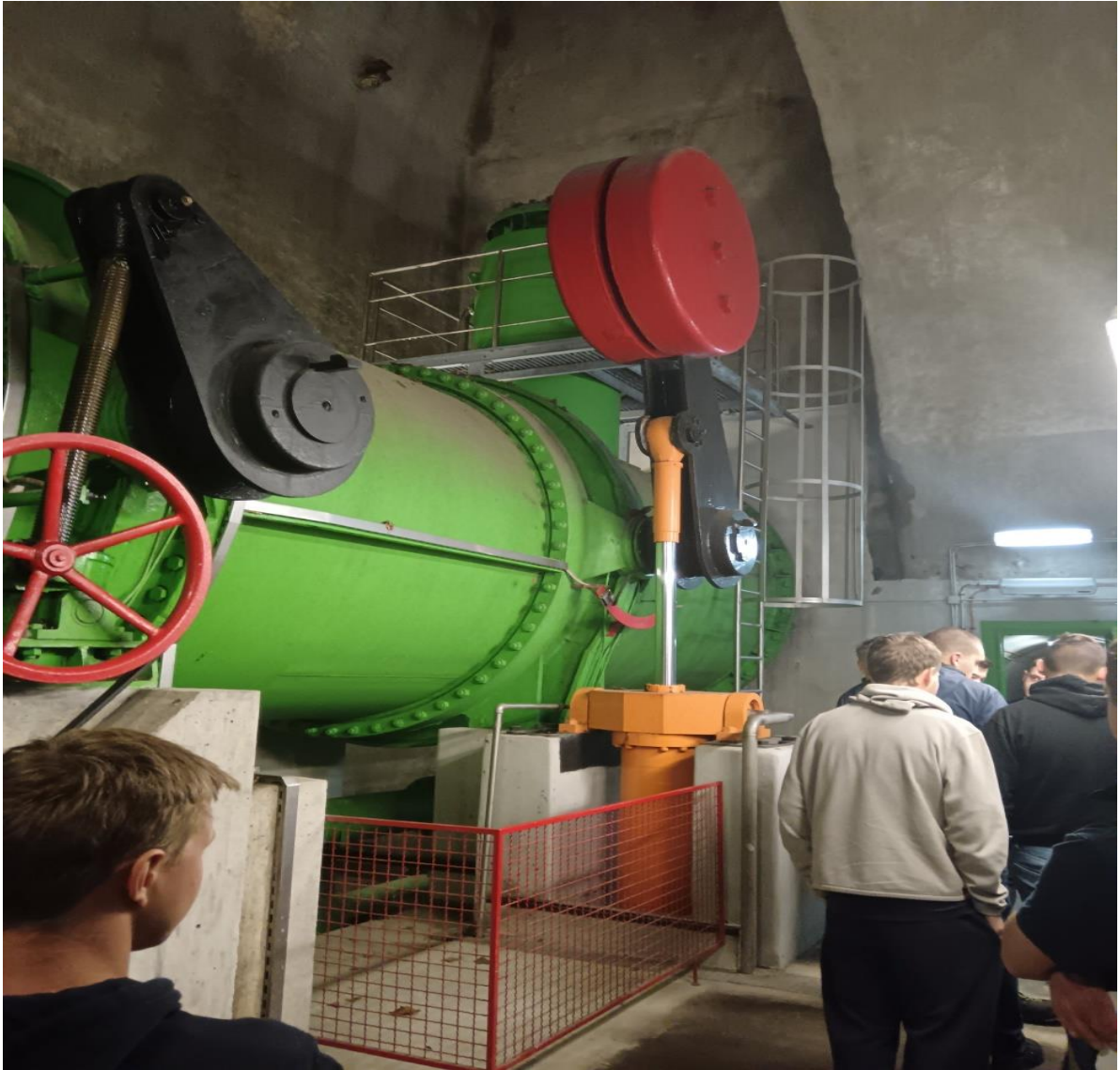
Slika 1: Zasun v tlačnem cevovodu, ki ga bo utež v padanju obrnila v cevi, da bo zaprl cev Potem smo se po stopnicah spustili 60 m nižje, kjer sta muzej in vhod v strojnico. Tik pred vhodom je eksponat francisove turbine.
