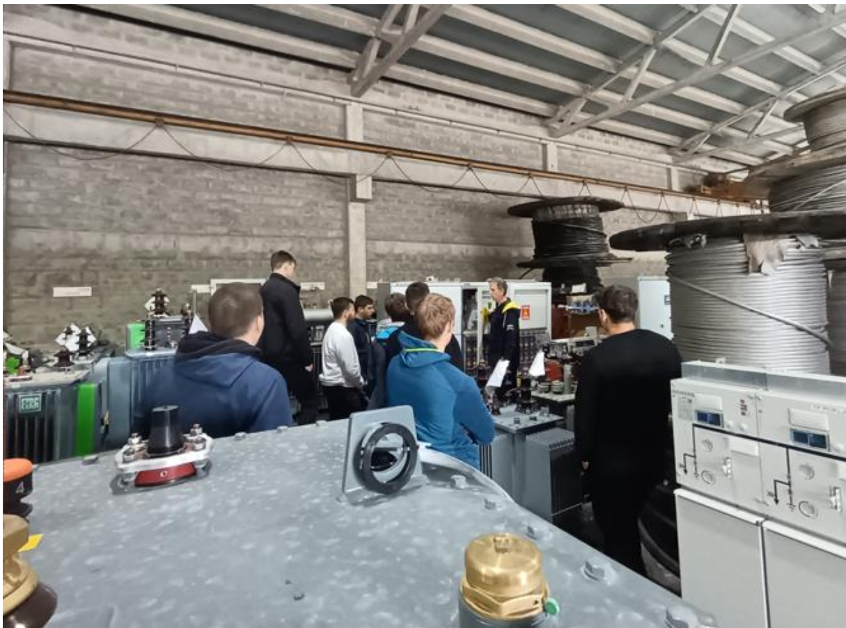
Slika 1: V skladišču distribucijskih TR, NN in SN kablov, NNR in SN blokov
